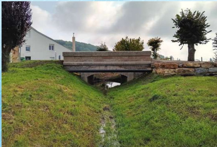
ROUVRES-LA-CHÉTIVE Pont de décharge de la Frézelle
