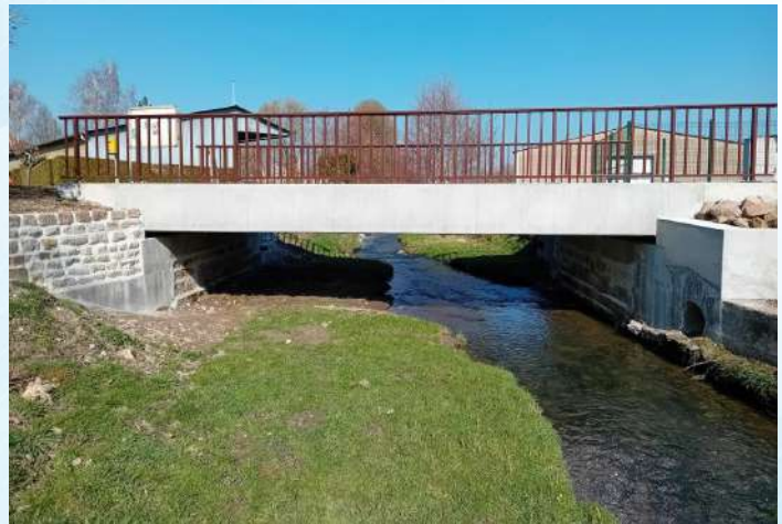
REMONCOURT Pont sur la Saule
