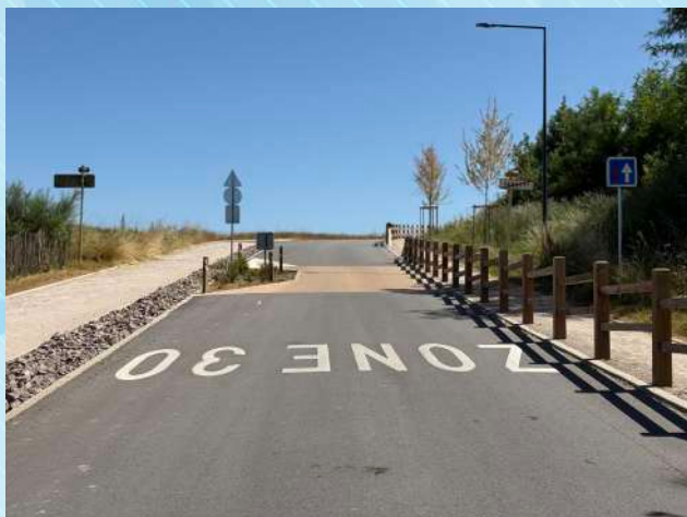
SANCHEY Aménagement de la route de Renauvoid RD 41
