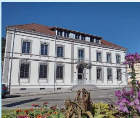
Rénovation de l'Ecole de VENTRON
